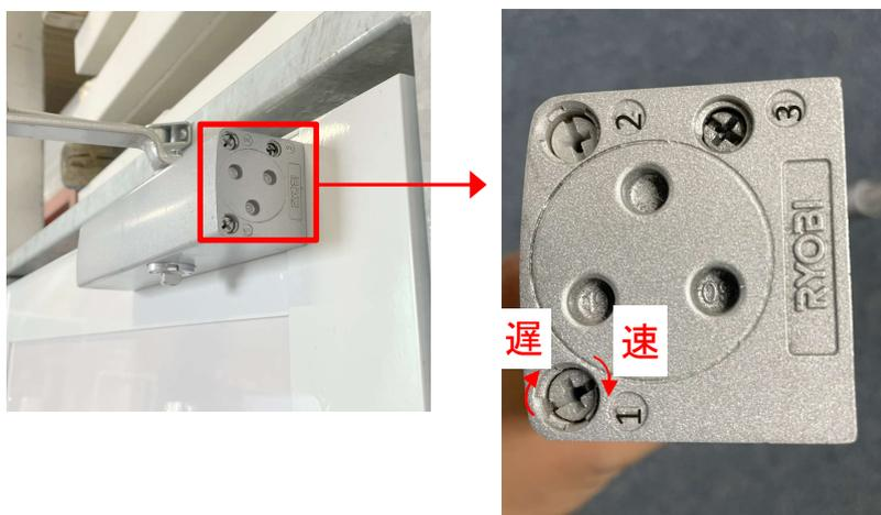
注意: ①扉の閉まるスピードが速すぎると、閉まる音により近隣クレームが発生する恐れがあるのでご注意ください。
