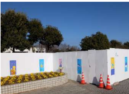
仮囲いパネル設置工事
