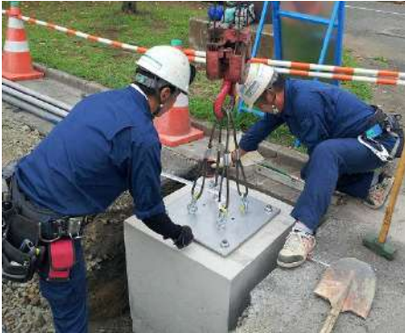
パネルゲート 置き基礎設置工事
