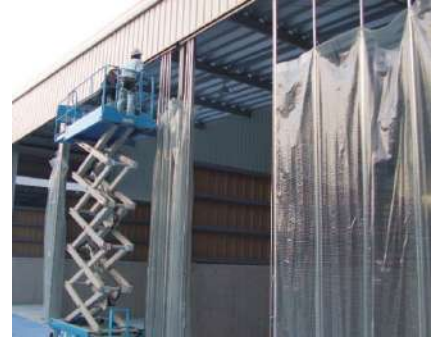
シートゲート設置工事
