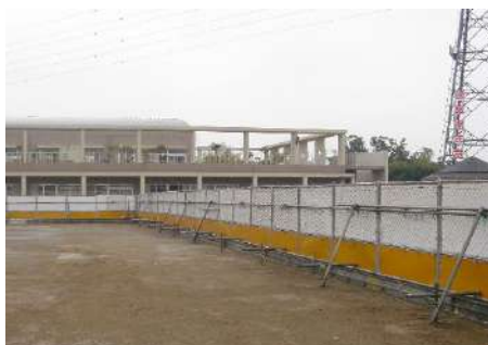
ガードフェンス設置工事
