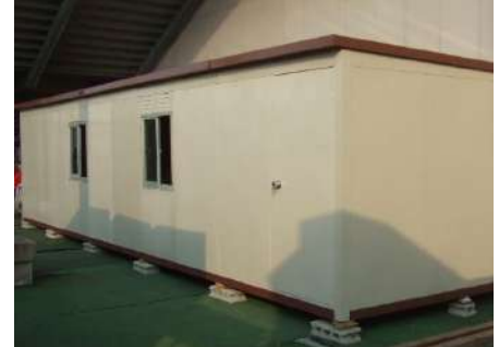
パネルハウス設置工事
