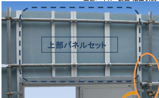
上部パネル 裏面 組立状況
