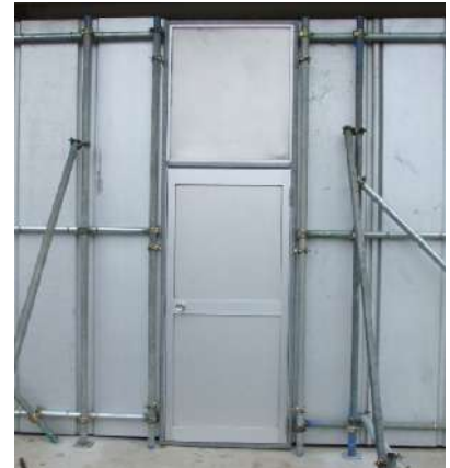
仮囲い・潜戸設置工事
