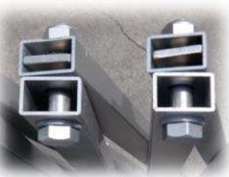
アルミ角パイプの鋼製芯材
