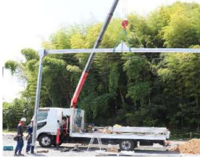
電動パネルゲート設置工事
