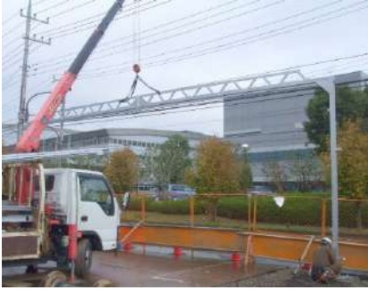
パネルゲート設置工事
