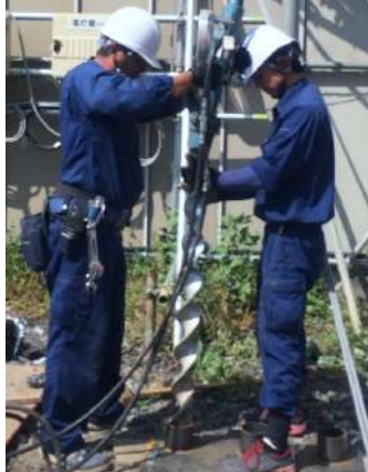
パネルゲート スパイク基礎設置工事
