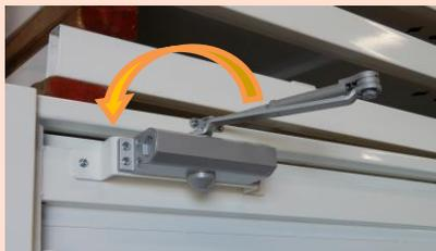
ドアクローザー:開閉速度の調整が可能
