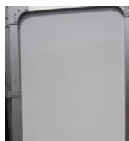
アルミ枠 アルミ複合板 t3mm
