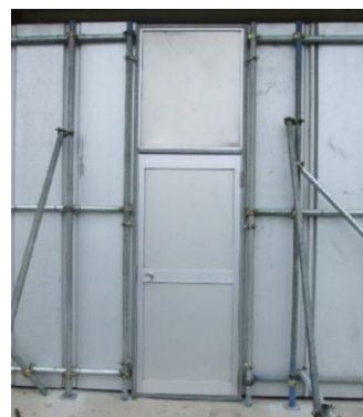
仮囲い・潜戸設置工事
