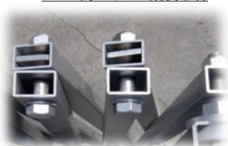
アルミ角パイプの鋼製芯材
