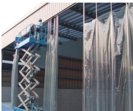
シートゲート設置工事
