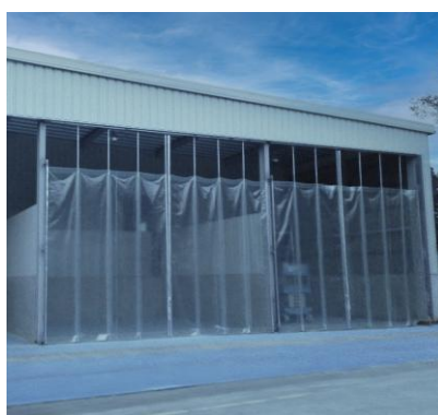
シートゲート設置工事
