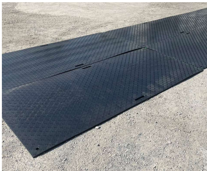
搬入通路での敷設
