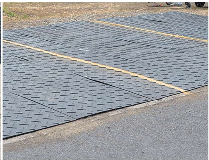
駐車場での敷設
